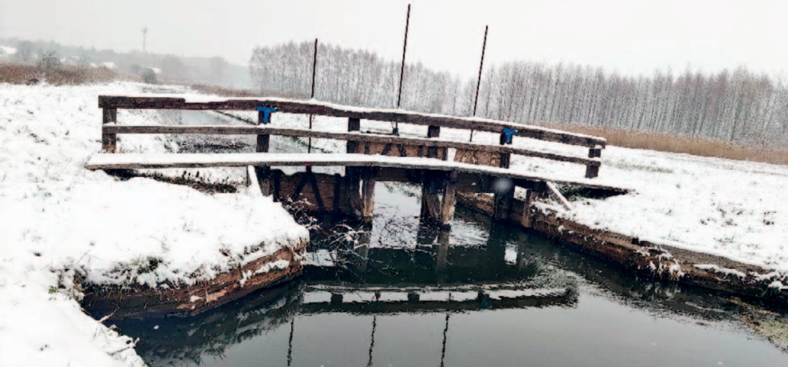
Drewniany jaz na Gniłej Obrze
