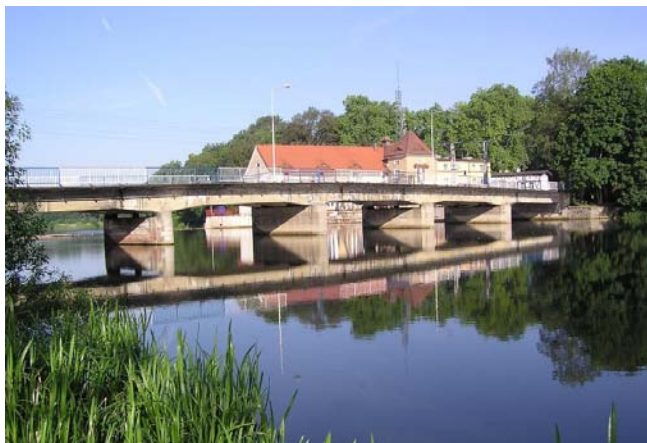
Elektrownia wodna na rzece Bóbr w Żaganiu
