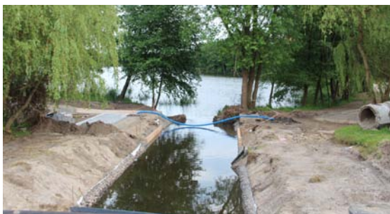
Budowa bulwaru przy kąpielisku Przytoczno
