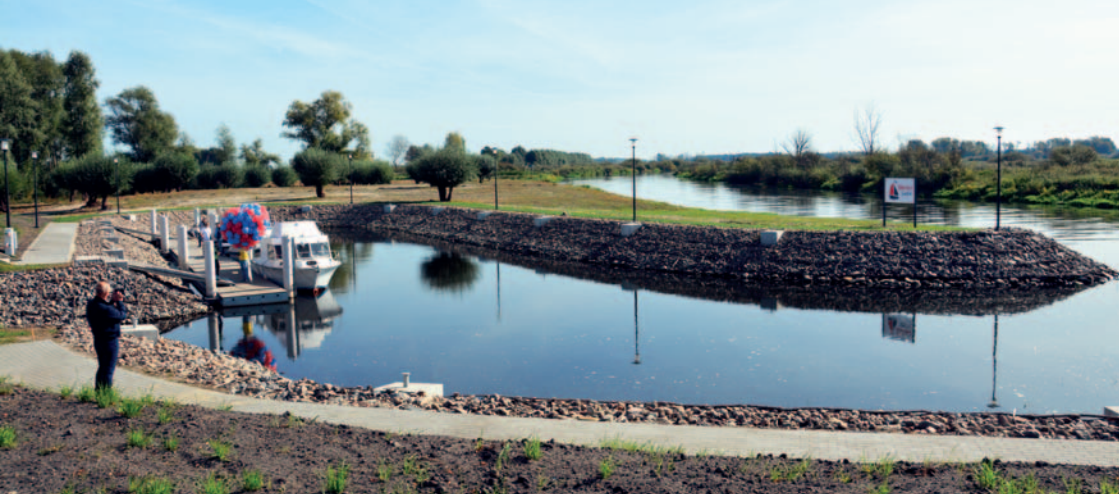
Port Marina w Santoku po remoncie
